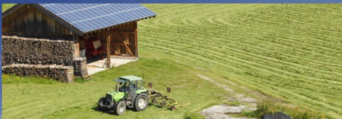
Instalaciones en ámbito rural
